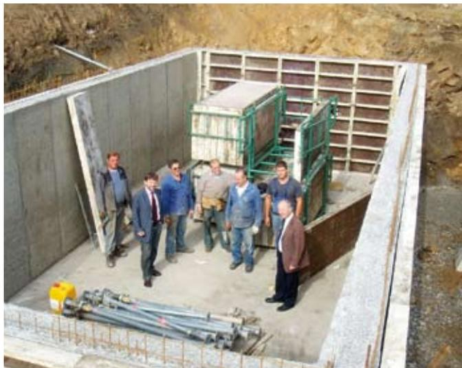
160 m<sup>3</sup> fasst der neue Löschwasserbehälter in der KG Reitern, der derzeit gebaut wird. Für die Versorgung des Behälters wurde ein eigener Brunnen geschlagen. Mit dem Überwasser aus diesem Löschwasserbehälter wird der bestehende Behälter neben dem Feuerwehrhaus versorgt. Die Kosten betragen rund 30.000 Euro. Bürgermeister Karl Simlinger und Stadtdirektor Anton Deimel beim Lokalaugenschein an der Baustelle.
