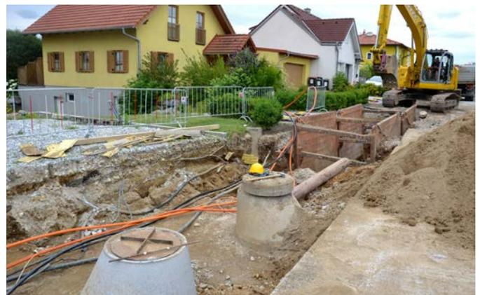
Weinhebergasse – Kabel- und Leitungsverlegung
