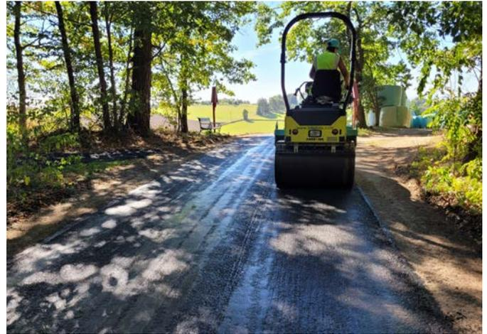
Der bestehende Asphalt des Rotkreuzwegs im Gföhleramt wurde mit einer bituminösen Dünnschicht überzogen und damit wieder versiegelt.
