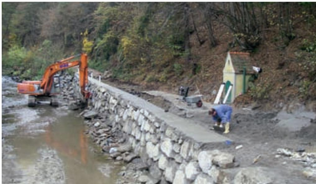
Sechzig Meter neue Steinmauern mussten zur Sicherung des Zwicklweges in Hohenstein nach dem Frühjahrshochwasser 2008 errichtet werden. Auftraggeber war die Stadt Gföhl.
