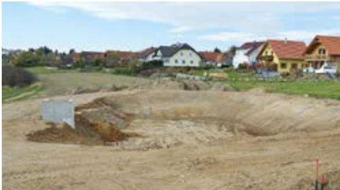
Das 1.760 m<sup>3</sup> große Rückhaltebecken dient zur Regenentwässerung des Betriebsgebietes und des Knotens Gföhl Ost.
