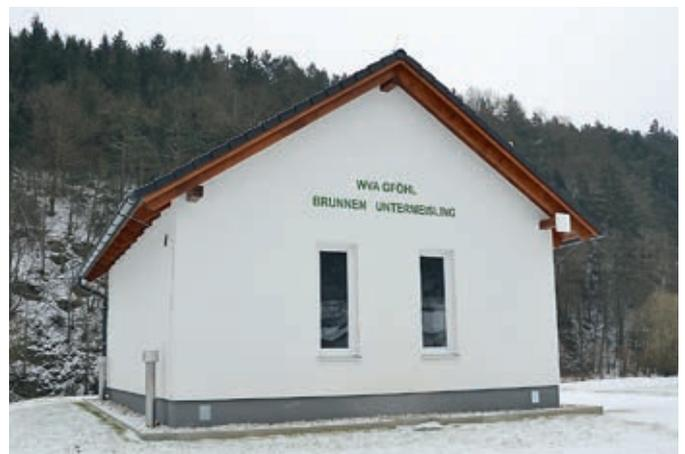
Hier wird das Wasser vom Brunnen mittels Enteisung und Entmanganung aufbereitet und in die bestehende Transportleitung Hohenstein – Gföhl eingespeist.
